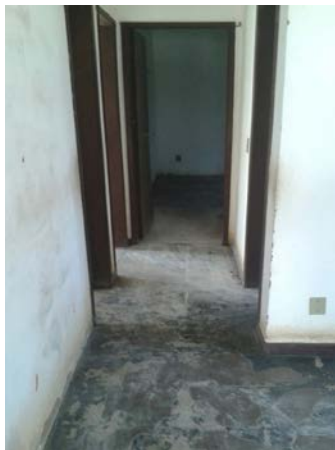
Figuras 5: Espaço interno da residência após a remoção.
